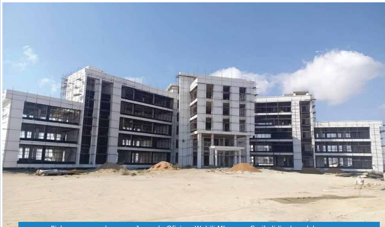
Picha ya muonekano wa Jengo la Ofisi ya Wakili Mkuu wa Serikali linaloendelea kujengwa katika Mji wa Serikali - Mtumba Jijini Dodoma.
